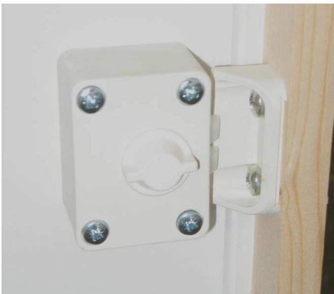
4 Detail Verriegelung
